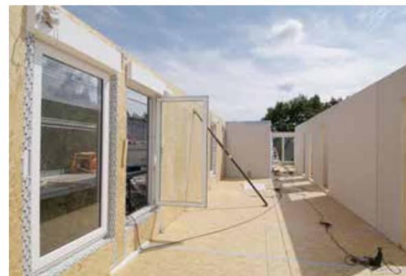
Montage der Bauteile in Holzrahmenbauweise bzw. Rohbauzustand vor Montage der Dachdecke (Quelle: Siemens Wohnungsbaugesellschaft/HAF)
