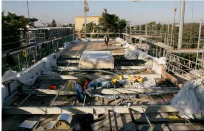
Tragwerk oberhalb der obersten Bestandsdecke in Stahlbauweise für die Aufstockung Siemens-Siedlung in Erlangen (Quelle: INFORMATIONSDIENST HOLZ / HAF)
