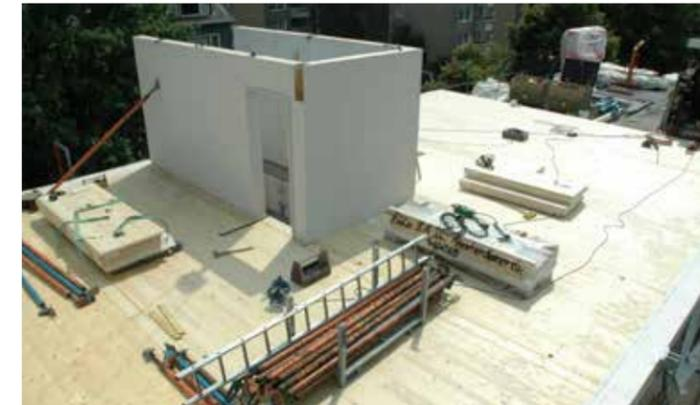
Montage von Wandelementen in Holztafelbauweise auf der neuen Tragkonstruktion aus Brettsperrholzelementen
