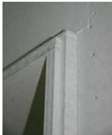
Fugenversatz der brandschutztechnisch wirksamen Bekleidung aus nicht brennbaren Baustoffen nach M-HFH HolzR 2004
